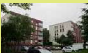
Résidence QUÉBEC 180 logements - Amiens
