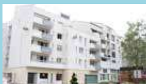
Résidence ALBERT DUGUÉ 97 logements - Creil
